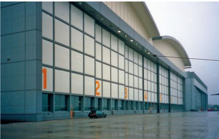
● Система передачи данных VAHLE POWERCOM® на воротах ангара компании Lufthansa, Гамбург
