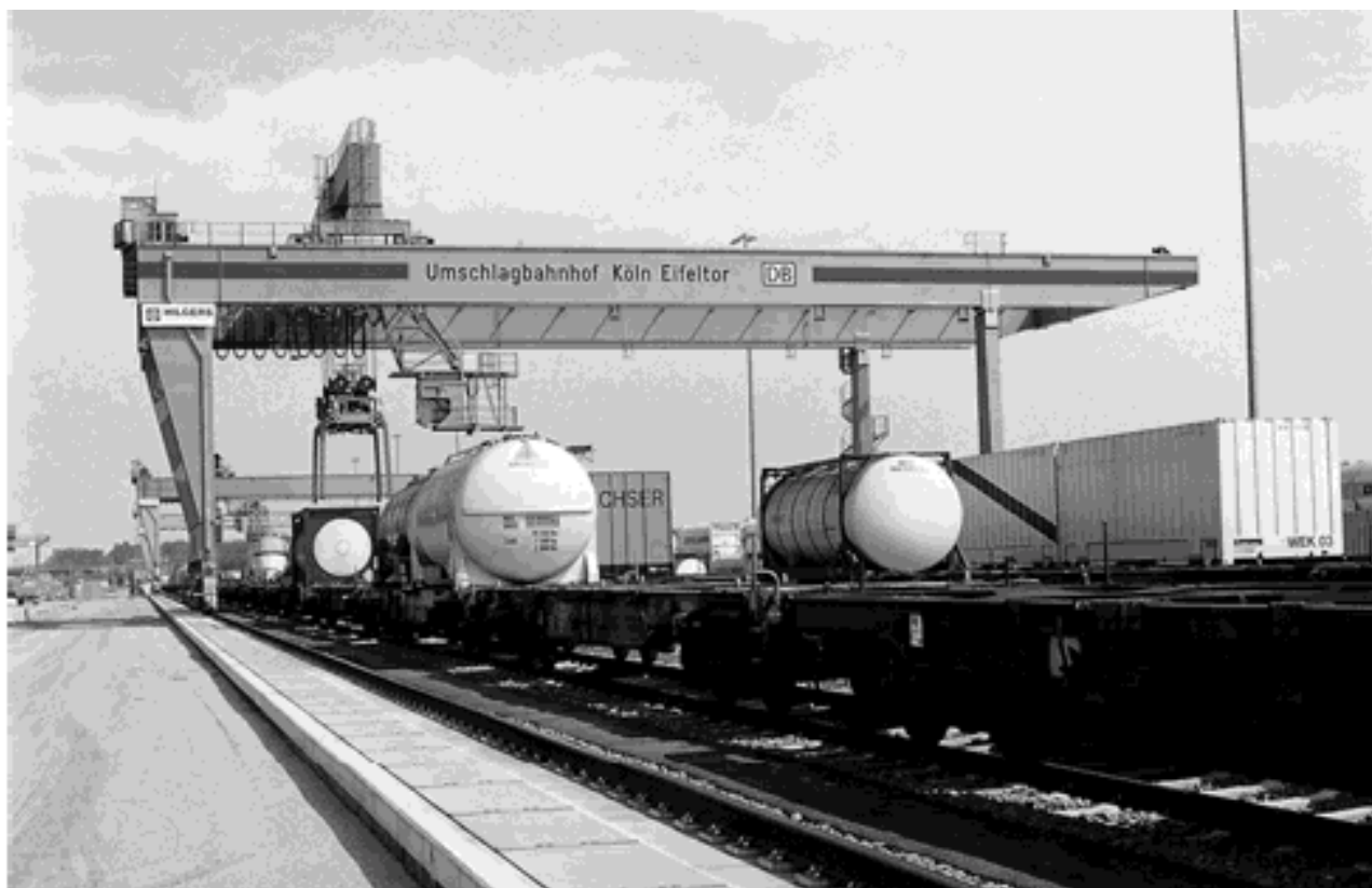
Траншейная троллейная система EID на контейнерном терминале.
