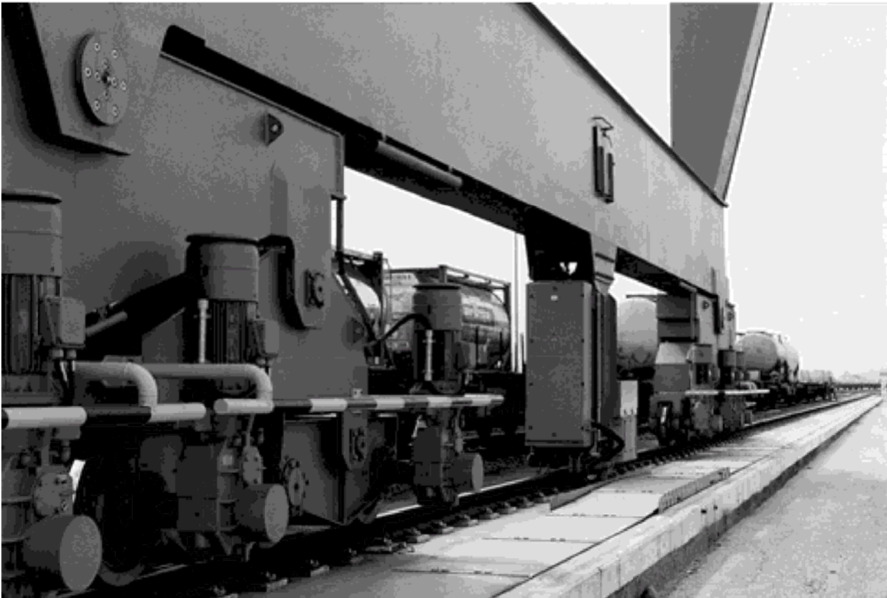
Траншейная троллейная система EID на контейнерном терминале.
